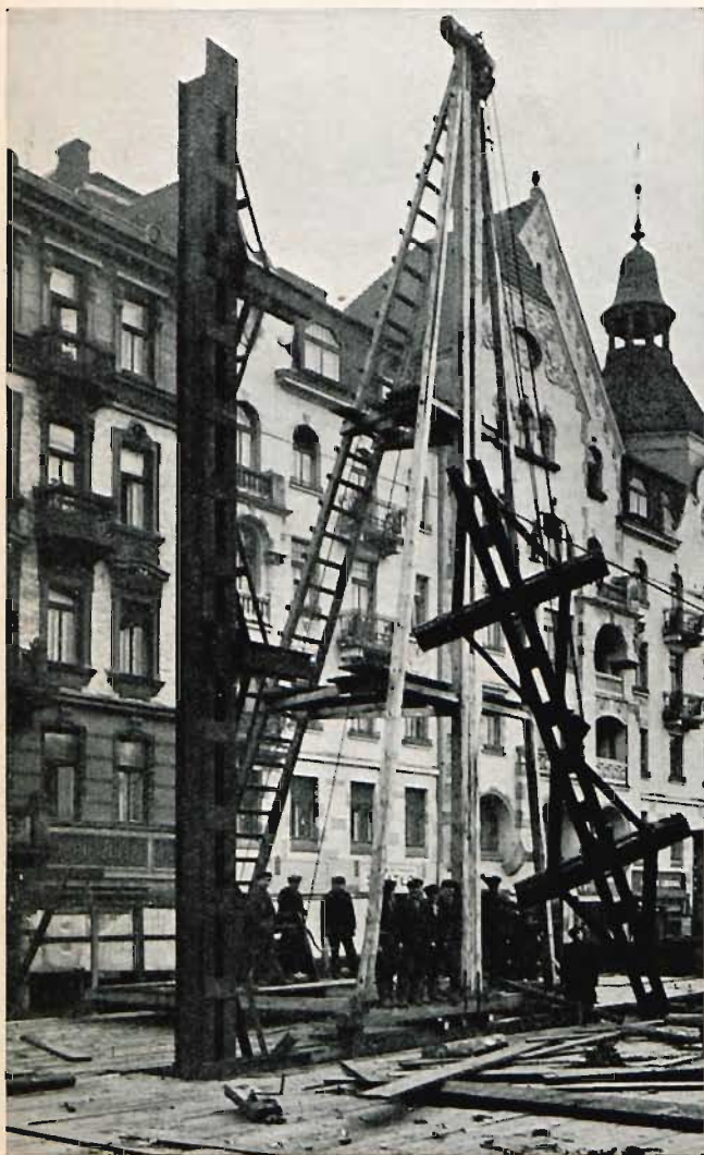
Rys. 14. Montaż dolnych części wieży i podnoszenie normalnego elementu.
