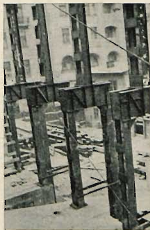
Rys. 12. Frontowe słupy środkowe w najniższych kondygnacjach.
