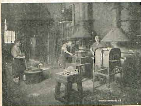
Kuźnia wyposażona w paleniska gazowe syst. Pharos.
