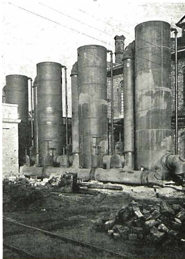
Budowa chłodników do gazu w gazowni na Woli.
