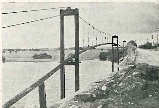
Widok mostu linowego dla gazociągu obok Rozwadowa.
