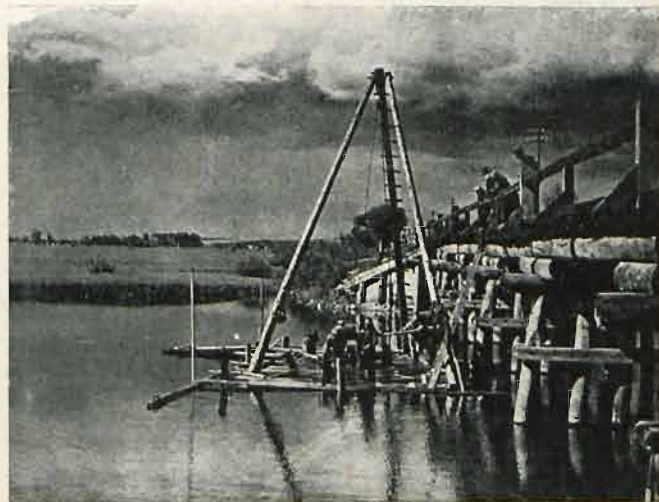
Budowa pomostu dla przekroczenia rzeki Brodnicy.
