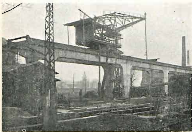
Budowa piecowi syst. Glover West w Gazowni Warszawskiej. Widok bieżni dla żorawia węglowego.
