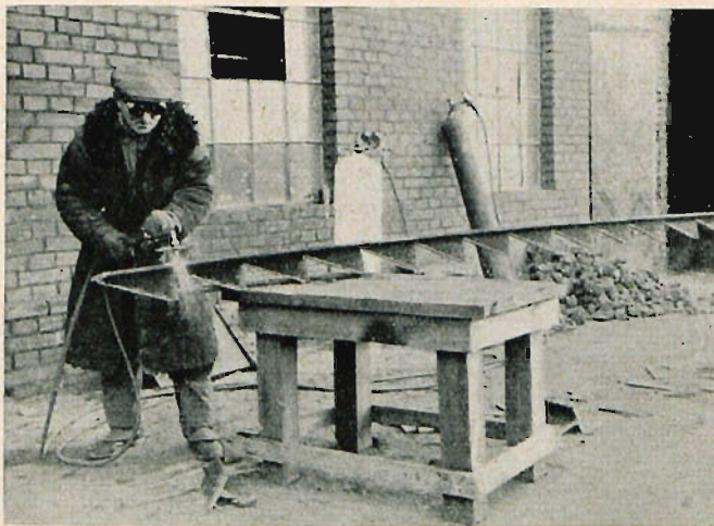
Fig. 15. Przecinanie palnikiem acetylenowo-tlenowym teownika na trójkątowe części, stosowane następnie w szczególności jak na fig. 14.
