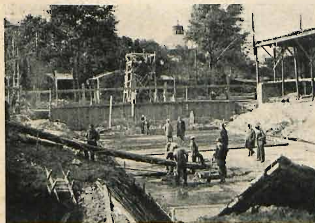
Widok ogólny na budowę piecowni syst. Glover-West. Górne zbrojenie środkowej płyty fundamentowej, w głębi pomocnicza wieża, wystająca z dołu wrzutowego do węgla, opuszczonego systemem kesonowym.
