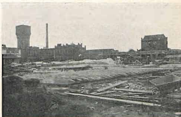
Budowa pali syst. Hennebicka.
