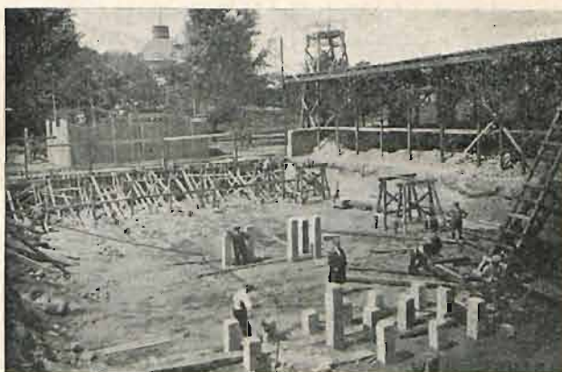
Zabijanie pali pod fundamenty.
