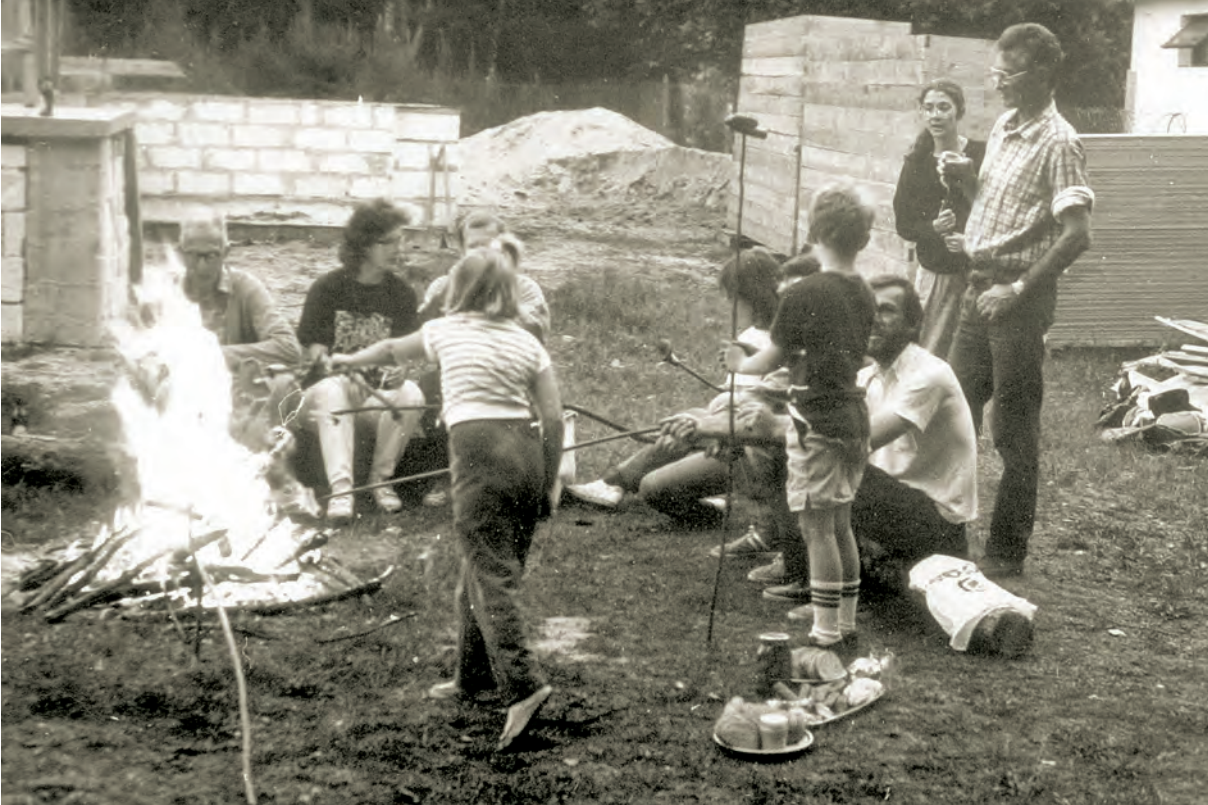
Na budowie domu Andrzeja Spika — po robocie (1989)
