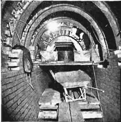
Rys. 7. Murowanie kanału.
