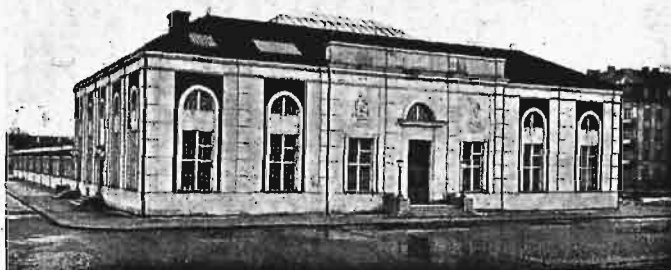
Rys. 3. Budynek Zakładów Filtrów Pospiesznych.
