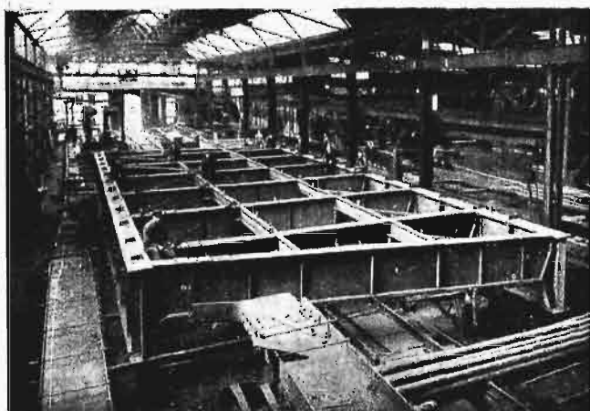
Rys. 22. Most spawany złożony w warsztacie.
