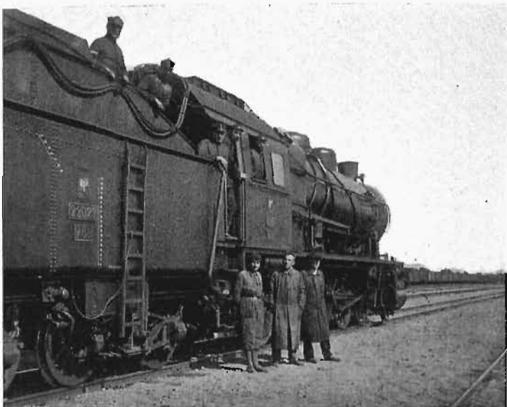
Połączenie parowozu kablami z wagonem dynamometrycznym: na tendrze (parowóz Ty 23).
