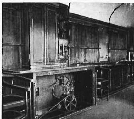
Nowy wagon doświadczalny: analizator chemiczny i pompa do ssania gazów.
