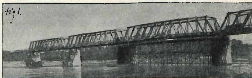
Rys. 1. Most na Sanie pod Zarzeczem rozpiętość 5 \times 40 = 200 m.
