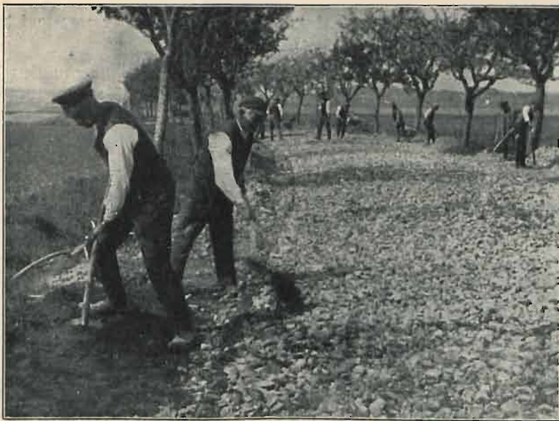
Rys. 9. Dodawanie „Komdrobitu“ do szutrowki.
