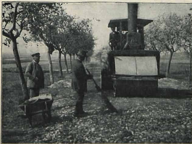
Rys. 10. Wałowanie drogi komdrobitowo-szutrowej.
