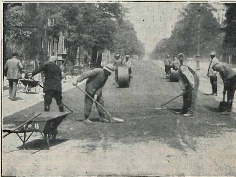
Rys. 5. Rozścielenie sztucznego asfaltu.
