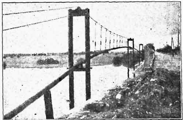
Rys. 1. Most linowy na przejściu gazociągu przez rzekę pod Rozwadowem.
