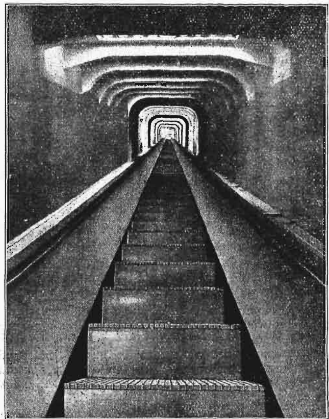
Rys. 1. Widok galerji, mieszczącej schody ruchome.
