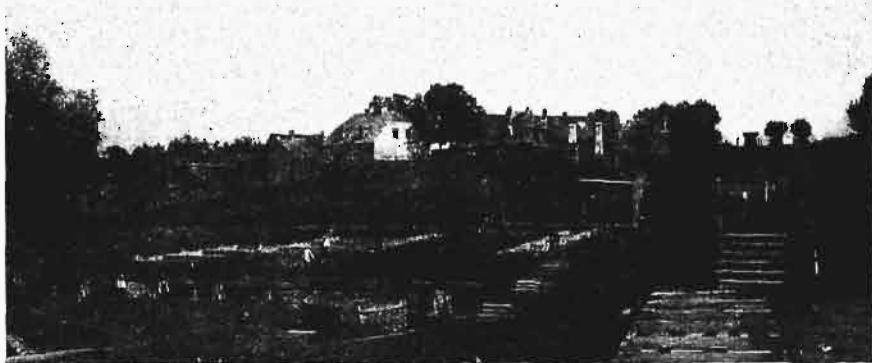
Rys. 1 Widok ogólny budynków i urządzeń Stacji Doświadczalnej.
