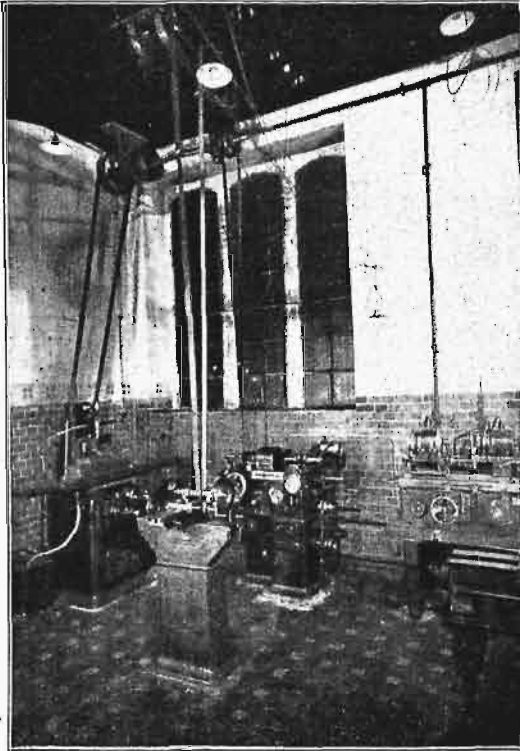
Rys. 15. Dział szlifowania. Widać szlifierkę do płaszczyzn o poziomem wrzecionie, szlifierkę do szlifowania wewnętrznego, oraz szlifierkę specjalną do sprawdzianów szczękowych.
