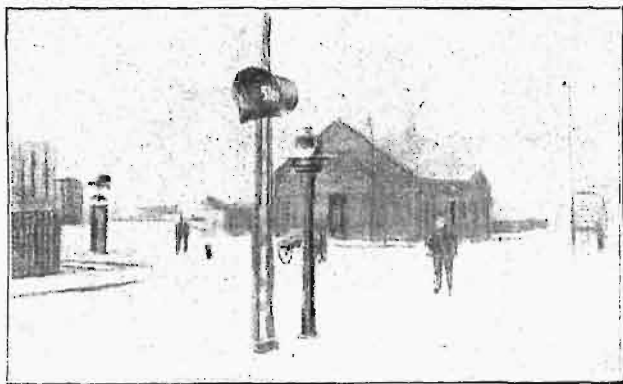
Rys. 5. Widok sygnалу optycznego i akustycznego na przejeździe kolejowym.
