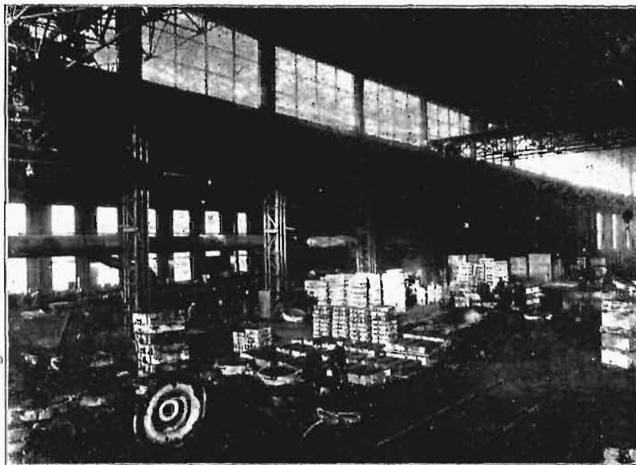
Rys. 1. Odlewnia staliwa w Zakładach Ostrowieckich w Ostrowcu. Widok formiarni i maszyn formierskich.
