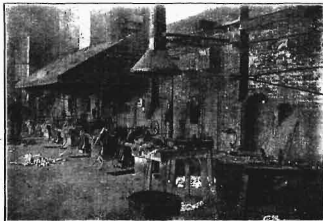
Rys. 3. Instalacja pieców ropowych tyglowych do przetapiania stopów glinu i miedzi w odlewni „Ursus”.
