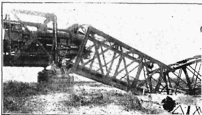
Rys. 15. Most na rz. Dniestr pod Samborem. Wobec tego, że most po uszkodzeniu do wody nie upadł, wypuścili nań oddziały ukraińskie parowóz, celem spowodowania gruntowniejszego uszkodzenia i większych utrudnień przy odbudowie prowizorycznej. Tymczasem, wypuszczony parowóz pod parą zatrzymał się na moście nad filarem, uderzywszy o górną rozporę pochylonego żelaznego dźwigara, uszkodzonego wybuchem.
