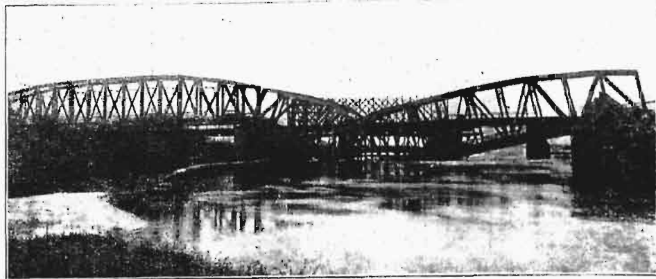
Rys. 1. Most na rz. Bugu pod Terespołem na szlaku Warszawa - Brześć, zniszczony przez wysadzenie dźwigara żelaznego w \frac{1}{3} rozpiętości mostu.
