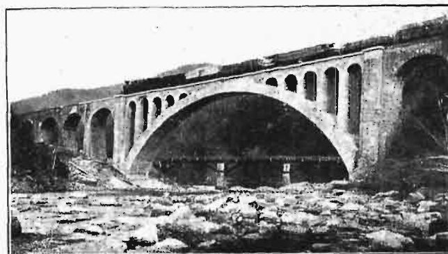
Rys. 29. Nowy most na rz. Prut w Jaremczu o rozp. sklepienia głównego 61 m, odbudowany w r. 1927.
