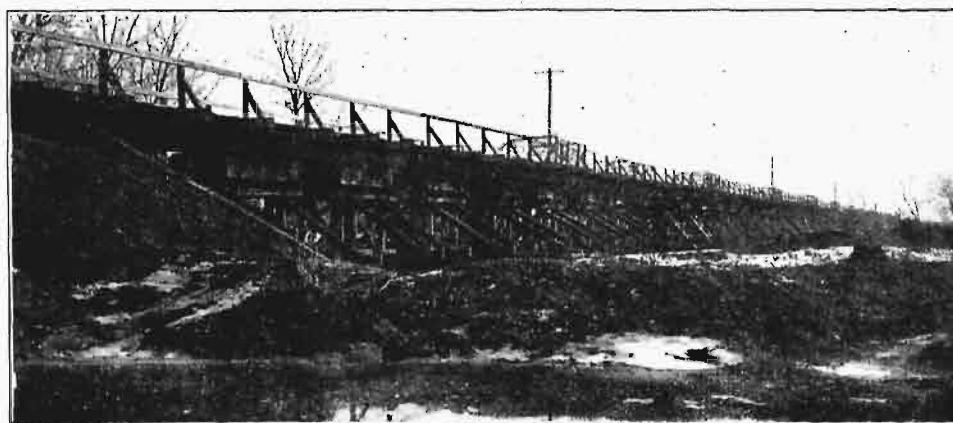
Rys. 34. Linja Skarżysko—Sandomierz—Sobów. Pierwotny most provizoryczny na rz. Wiśle pod Sandomierzem, długości 631 m.
