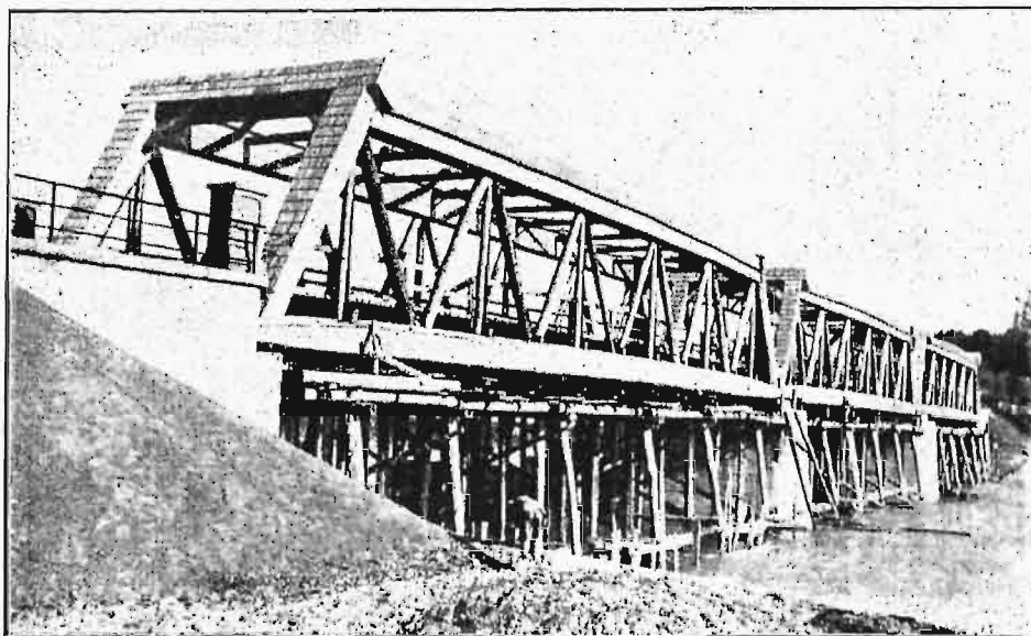
Rys. 2. Widok drewnianego kratowego mostu drogowego z rusztowaniem dolnem w Lisku.
