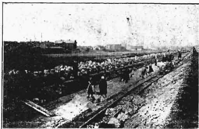
Rys. 10. Budowa koryta Rawki.
