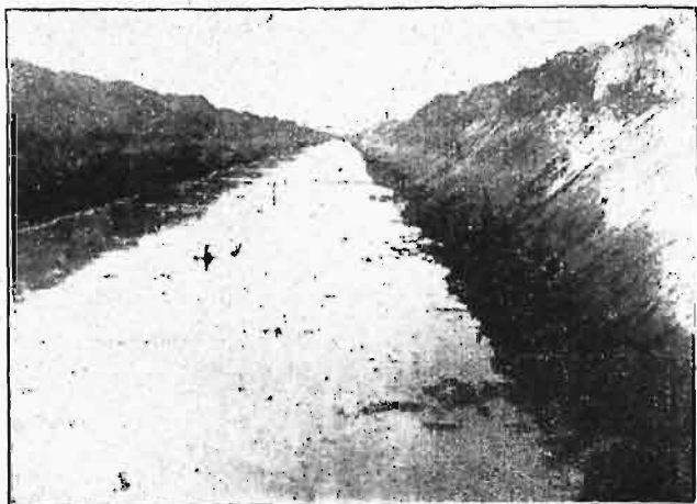
Rys. 12. Wykop kanału osuszającego na Polesiu.
