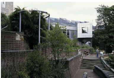
94. Prolongación del proyecto. El "Saliente" del espacio ubicado en el 2-do nivel se dirige hacia adelante, al espacio externo. Museo del Arte Contemporáneo , Mönchengladbach, 1972-1982, H. Hollein
