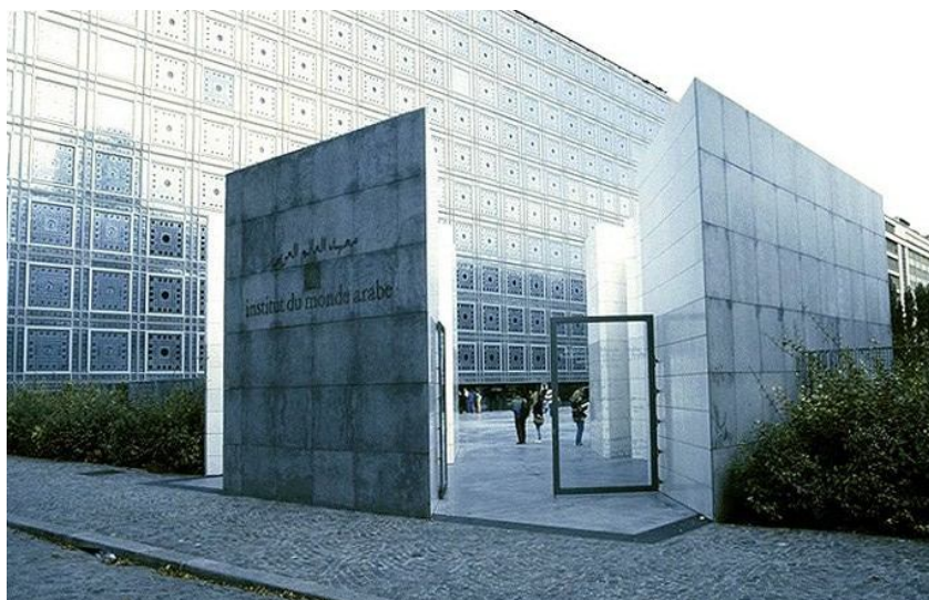
143. Masyw elewacji – uspokojenie. Instytut Świata Arabskiego, Paryż, J. Nouvel
