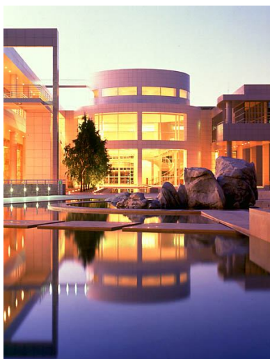
67 b. W tym przykładzie (noc) właściwa lub błędna orientacja schodzi na dalszy plan. Centrum Getty, Santa Mónica, Kalifornia, 1984–1997, R. Meier
