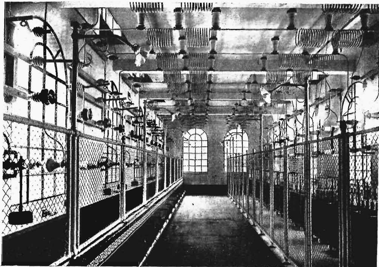
Rys. 19. Ochronniki kondensatorowe 32 kV w Hauterive.
