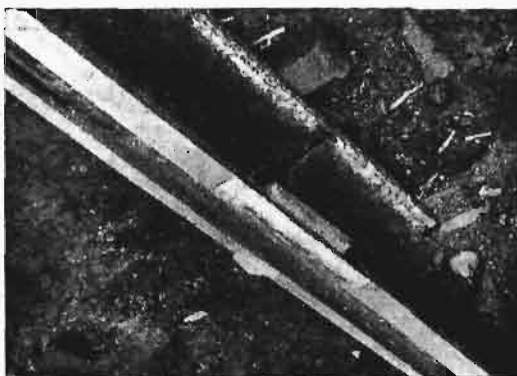
Rys. 6. Szyna spawana na styk po wykonaniu.
