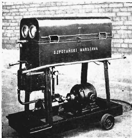
Rys. 1. Prasa do sączenia oleju.
