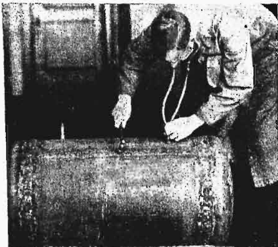
Rys. 5. Badanie spoiny stetoskopem.
