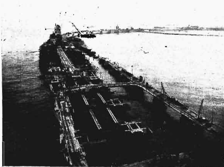
Rys. 9. Widok moła w trakcie budowy.
