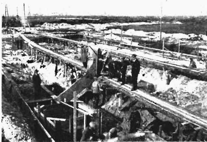
Rys. 11. Wykop pod fundamenty hali maszyn, odwodniony szeregiem studzien, założonych nazewnątrz.
