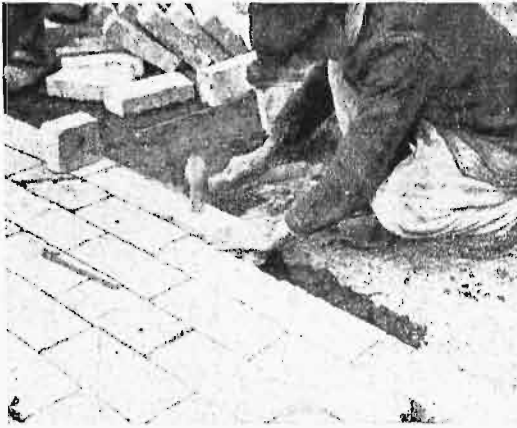
Rys. 1. Układanie bruku betonowego.
