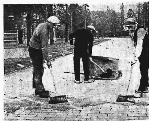
Rys. 2. Zalewanie spoin zaprawą cementową.
