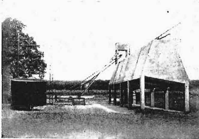
Rys. 6. Doświadczalne komory fermentacyjne syst. Anger.
