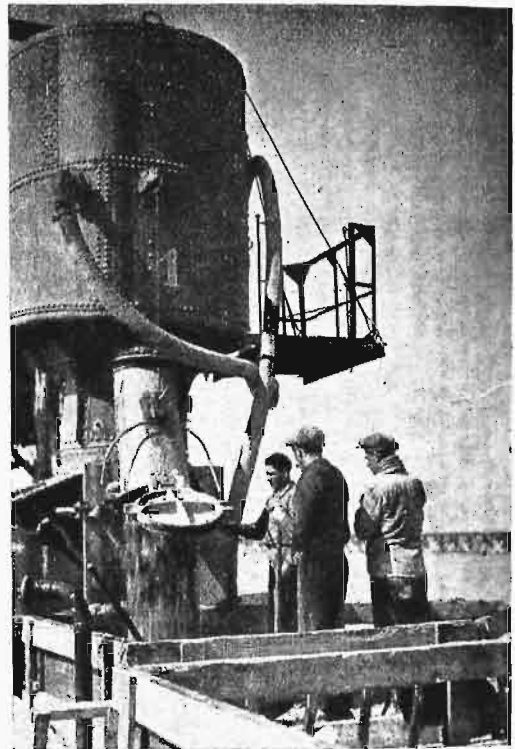
Rys. 11. Wydobywanie materiału z dna morskiego przez śluzę kesonu.
