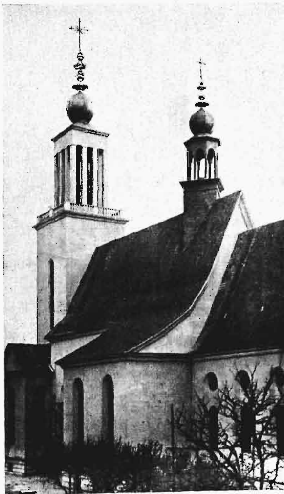
Rys. 1. Widok fragmentów brył kościoła z południo-zachodu.
