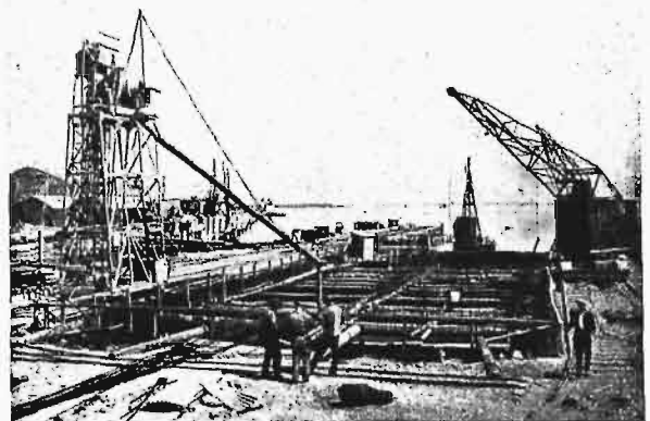
Rys. 8. Dok suchy, w którym wykonywa się kesony.
