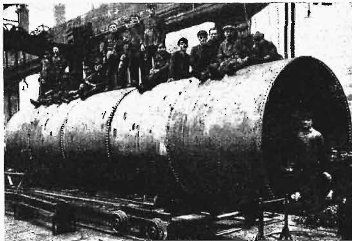
Zbiornik o pojemności 50 m 3 dla stacji hydroforowej P. K. P.
