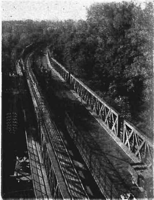
Rys. 7. Widok małych przęseł przed wzmocnieniem.
