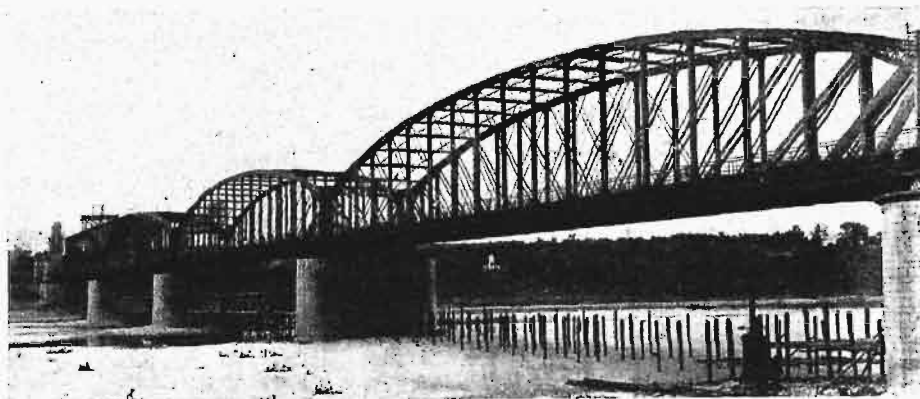
Rys. 1. Widok prześel dużych mostu toruńskiego przed wzmocnieniem.
