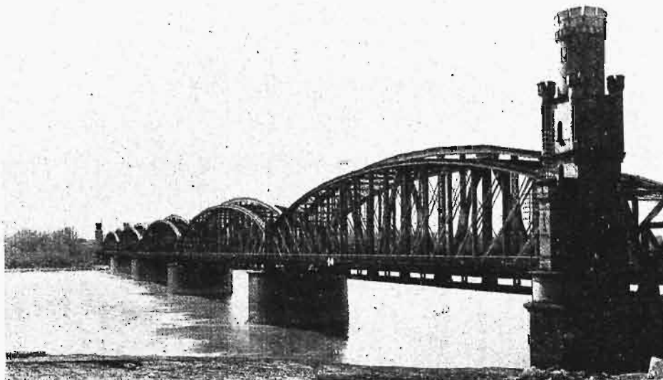
Rys. 6. Widok dużych przęsł po wzmocnieniu.
