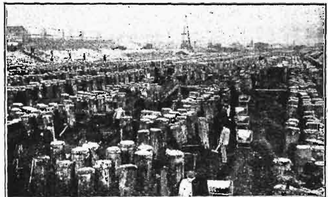
Rys. 2. Fundament palowy.
