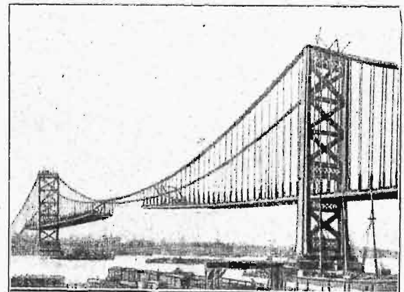
Rys. 55. Początek powrotnego ruchu dźwignika montażowego ku filarowi.
