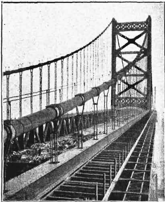
Rys. 21. Widok połączenia wieszaków z linami głównymi.
