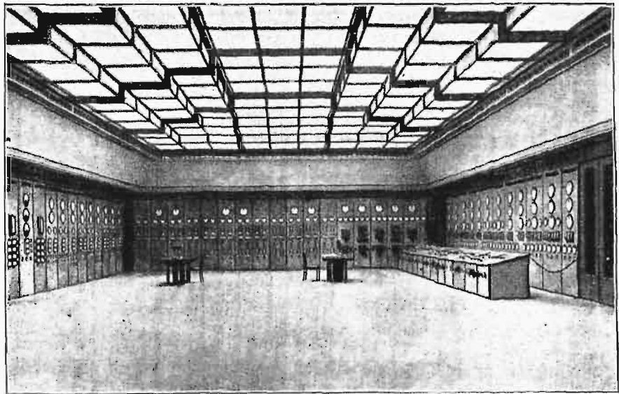
Rys. 9. Posterunek centralny elektrowni.
