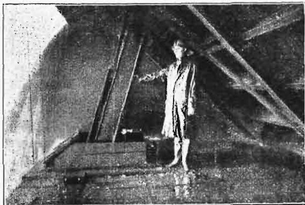
Rys. 4. Spód ustroju żelaznego kłapy typu 5 (rys. 2).
