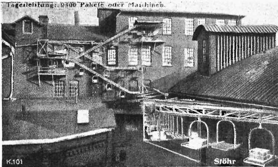
Rys. 12. Transport kolejką wiszącą na większe odległości.
