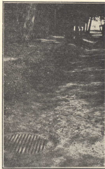
Fot. 3. Kratka ściekowa w rynsztoku w pobliżu bramy posesji Nr. 13, z której ścieki wierzchem do niej spływają, gdzie napotkano na obfite ślady substancji olejowych.
