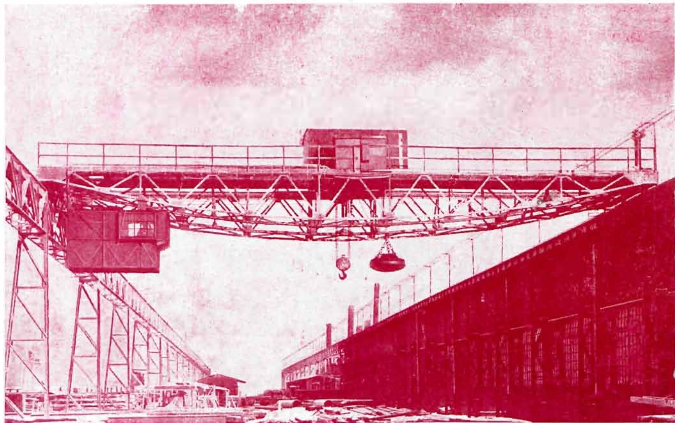
Suwnica z hakiem i magnesem, obsługująca składnicę odlewni.
