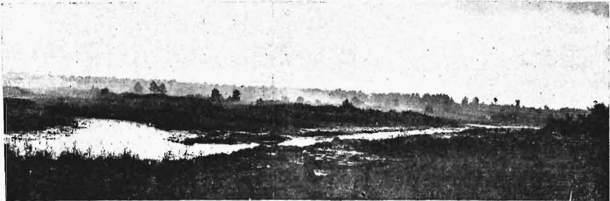
Rys. 4. W kilka minut po wybuchu wytworzyło się nowe proste koryto rzeki Orzyc o wymiarach: szerokość u góry 7—8 m, głębokość 1,8—2 m.
