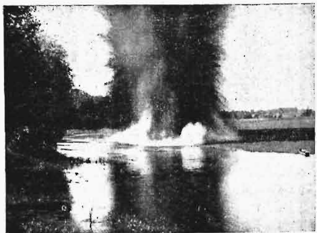
Rys. 5. Wybuch do wykonania kanału, prostującego koryto rz. Orzyc koło wsi Drażdzewo.
