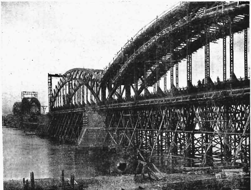
Rys. 3. Widok mostu podczas montażu przęseł.
