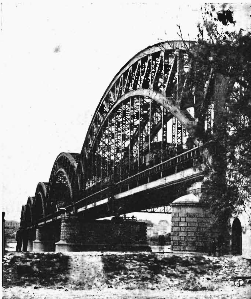
Rys. 4. Widok ukończonego mostu podczas próbnego obciążenia.
