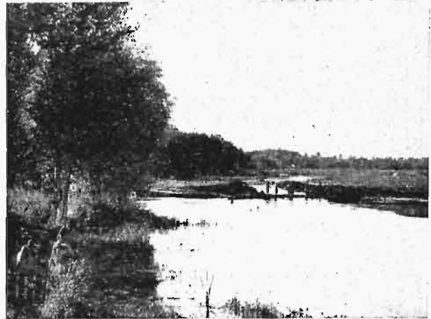
Rys. 6. Widok kanału (szerokość u góry 7—8 m, głębokość 1,8—2 m), wykonanego przy pomocy dynamitu celem wyprostowania koryta rzeki.
