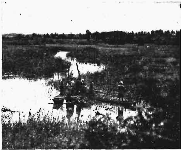
Rys. 1. Załadowywanie dynamitu do otworów strzelniczych na linii środkowej przyszłego przekopu na rz. Orzyc.
