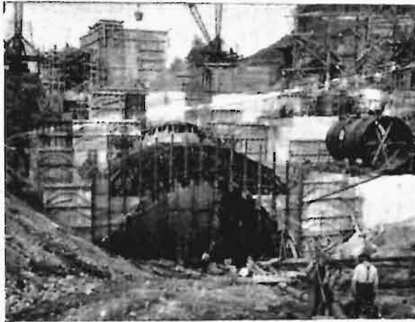
Rys. 28. Sklepienie - fundament zakładu. Widac deski szalowania, zawieszane na konstrukcji żelaznej.
