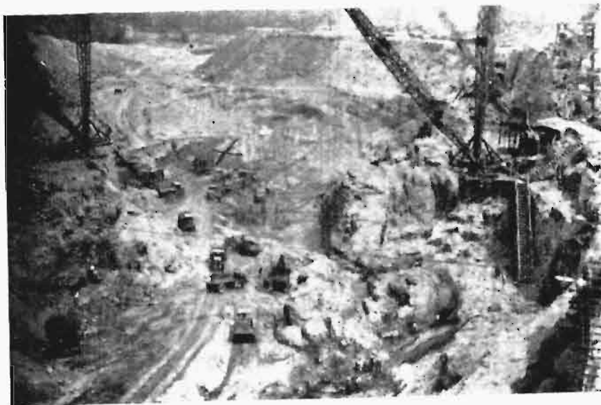
Rys. 12. Wykop w korycie rzeki.
