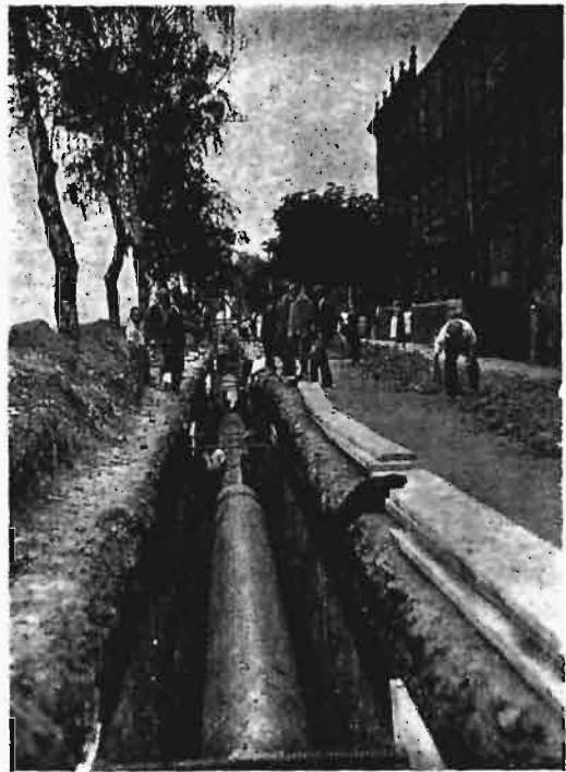
Rys. 2. Układanie rurociągu z rur \varnothing 750 mm, długości 12 m, z kutego żelaza.
