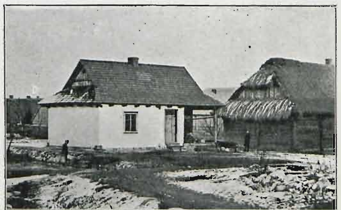
Dom Kozłowej w Olszanicy.
