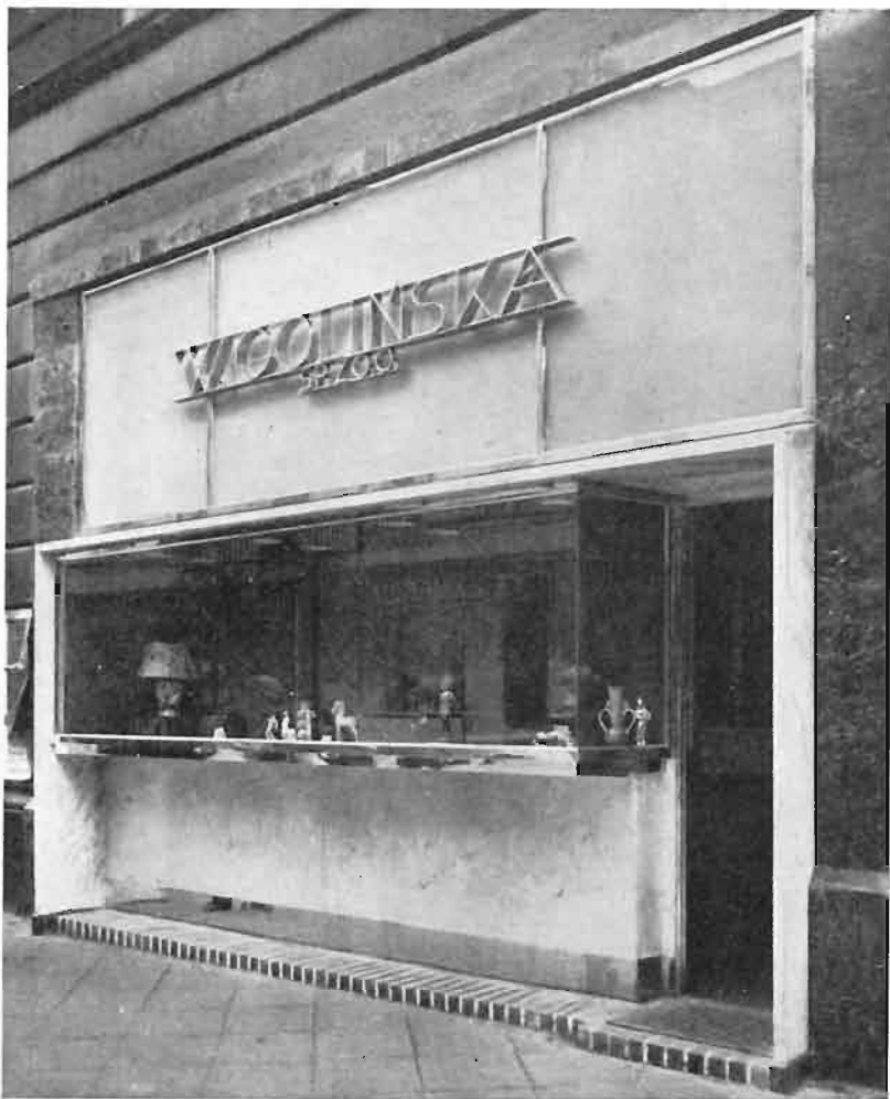
181. Proj. Inż. Arch. Edward Eber (W-wa). Widok od ulicy sklepu F-my W. GOLIŃSKA Sp. z o. o. w W-wie przy ul. Mazowieckiej. Elektr. odmrażacz szyb wewnątrz wystawy, instal. oświetl. elektr. oraz armatury wyk. F-ma „ELEKTROTERMJA” (W-wa). Roboty marmurowe zewnętrzne i wewnętrzne wyk. F-ma T. FELKEL (W-wa). Meble z F-my „WNĘTRZE” przedst. fabr. mebli B-cia Koerpel (W-wa).
