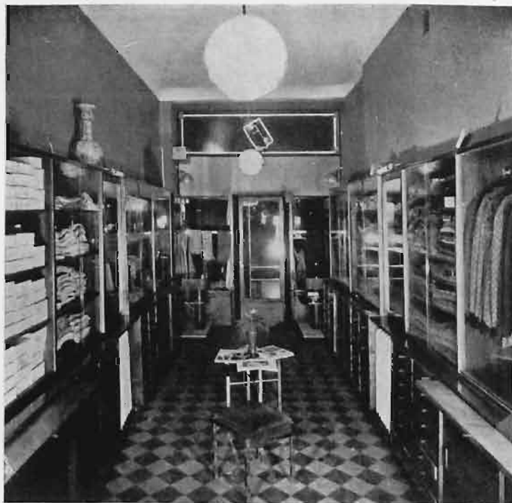
198 — 199. Proj. Art. Mal. M. Eljowicz (W-wa). Elewacja i wnętrze F-my „A. FRENDLER“ w Warszawie przy ul. Marszałkowskiej Nr. 101. Roboty metal. oraz napisy wyk. F-ma „W. PUCHALSKA i S-ka“ (W-wa). Tapety z F-my S. RAWICKI (W-wa).
