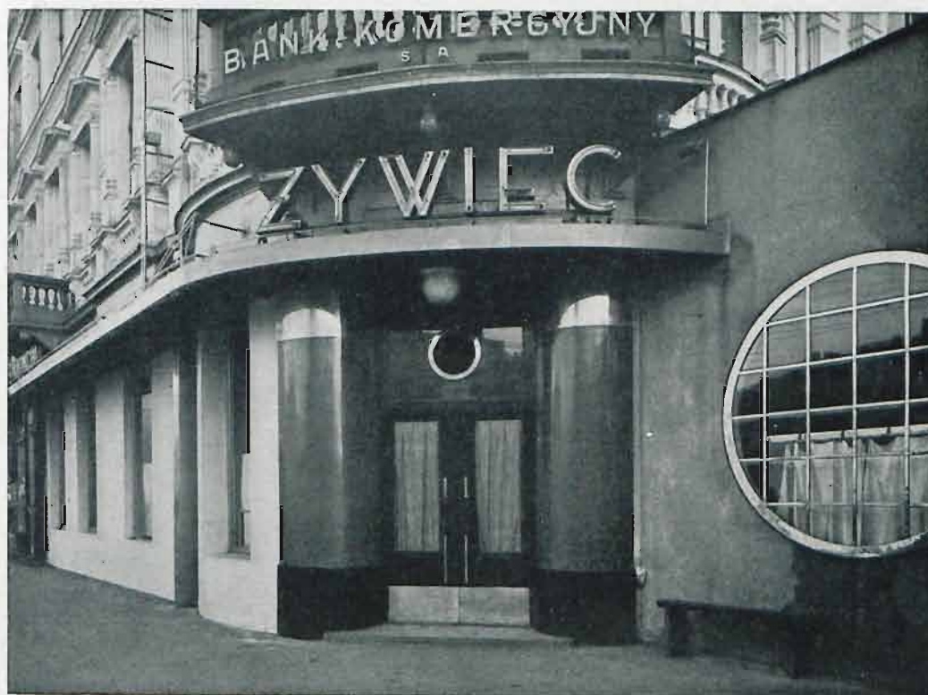
Restauracja „Żywiec“. Wejście. Wentylacje wyk. firma Wytwórnia Wentylatorów inż. Adam Feilchenfeld, Warszawa.
