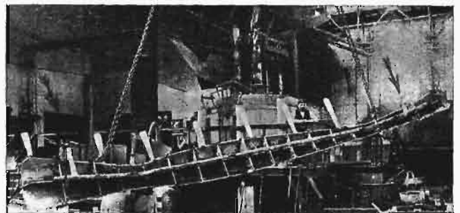
Rys. 4. Odlew dziobnicy okrętowej po wyjęciu z formy. wa, formowane maszynowo, które po oczyszczeniu wkłada się do odpowiednich form, ustawionych w szeregu obok siebie.
